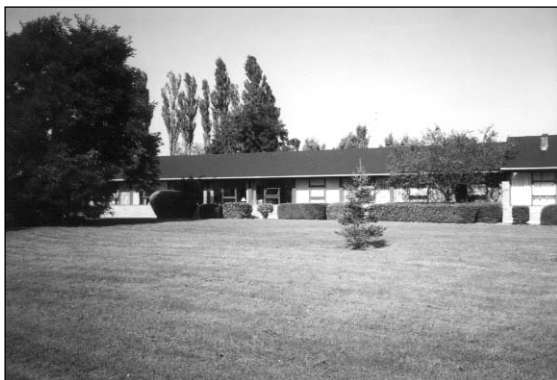
I dag anvendes nogle af de sidst byggede bygninger på Rødbygaard/Kofoedsminde som "alderdomshjem" for multihandicappede. Dette foto viser Bo- og nabo-skabet Syrenvej. Foto: Grethe Holm.
